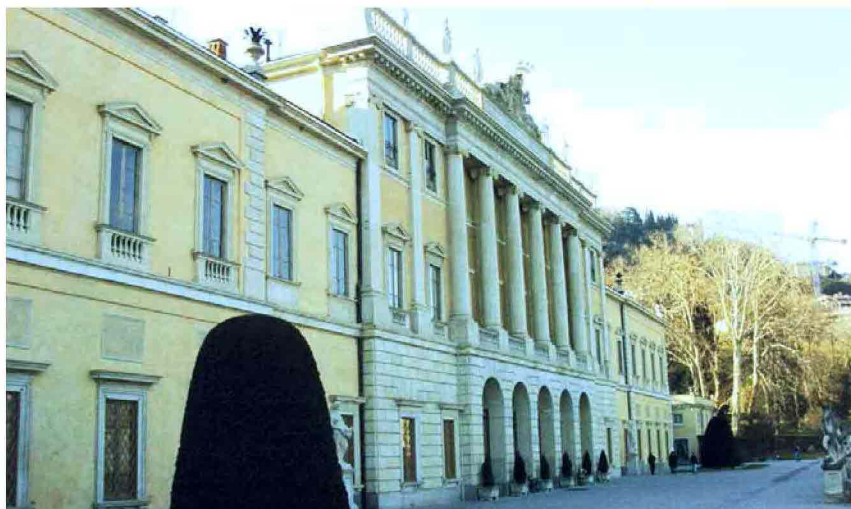
La ristrutturazione di Villa Olmo è uno dei progetti che potrebbe ricevere la quota massima di contributi della Fondazione Cariplo
