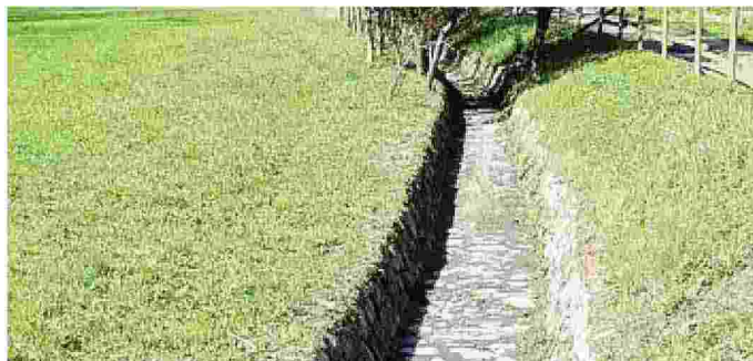
Il tratto di canale realizzato per recuperare la roggia San Pietro
