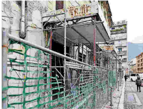
Sopra, le impalcature montate in questi giorni sulla facciata dell'ex Politeama. Sotto, il cinema Astra, inagibile da due anni (foto Colombo)
