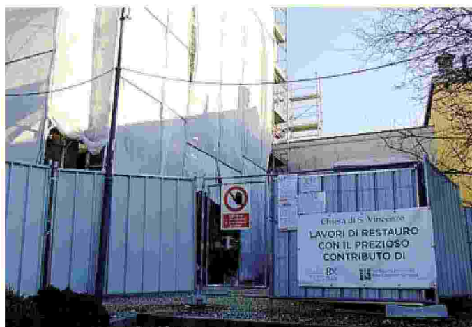
L'ingresso del cantiere della piccola chiesa di Cermenate
